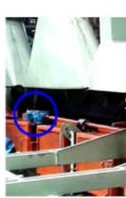
Reparación e instalación del motoreductor
