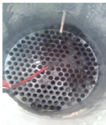
Figura 3. Limpieza de tubos del intercambiador I-90 utilizando hidrojet
