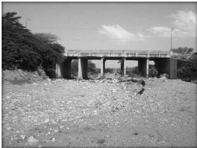
Figura 1: Puente Sobre La Quebrada Atarigua. Fuente: Propia.
