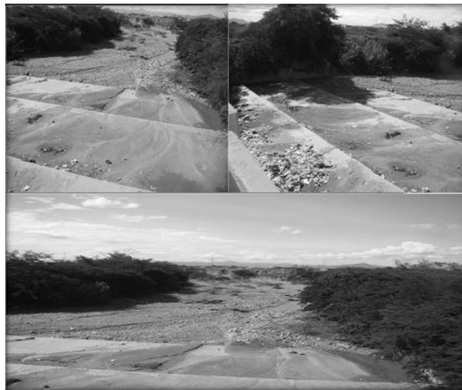
Figura 2: Obra de protección aguas abajo del puente. Fuente: Propia.
