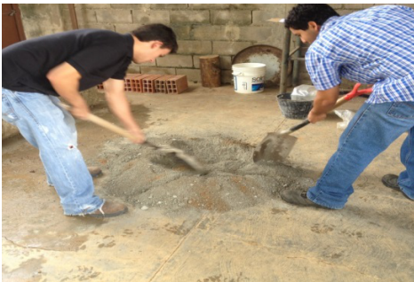
Figura 4: Realización de la mezcla.
