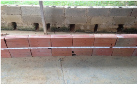
Figura 2: Colocación de anime de división de bloques.
