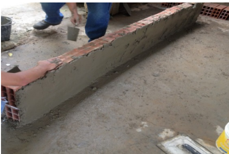
Figura 5: Acabado final de muro frisado.
