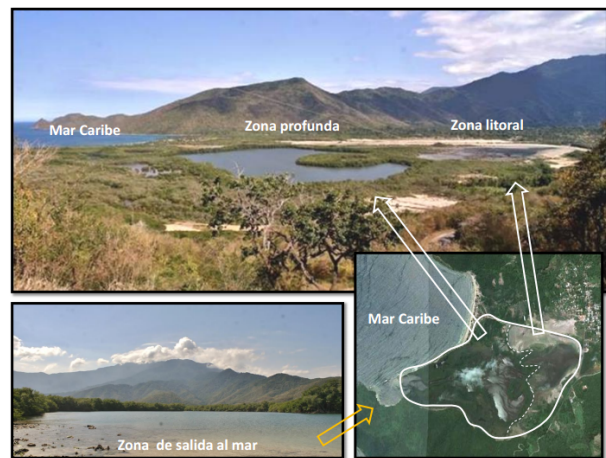
Figura 1: Vista satelital y fotografías panorámicas de la Laguna la Bocaina, mostrando el área total. Fuente: Imágenes: Google Earth, 2012 y Fotografías Sabina Caula.
