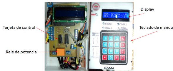
Figura 5: Tablero de mando implementado.
