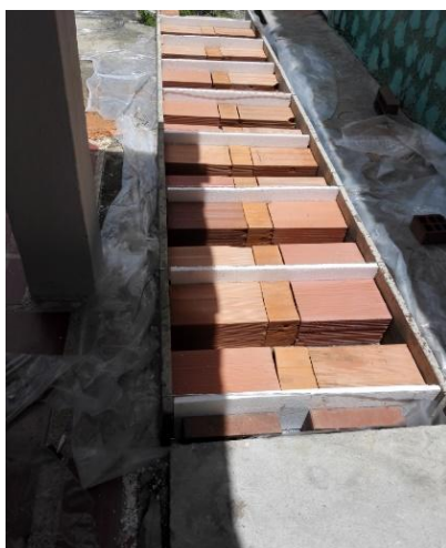
Figura 2: Construcción de modelos de losas.
