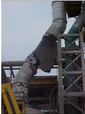
Figura 1: Falla catastrófica en línea de tope de un Regenerador de la FCC [3].
