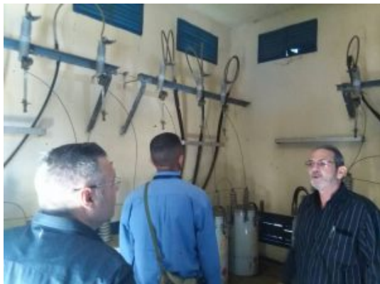
Figura 2: Supervisión de las labores relativas a la emergencia eléctrica de la facultad [1]
