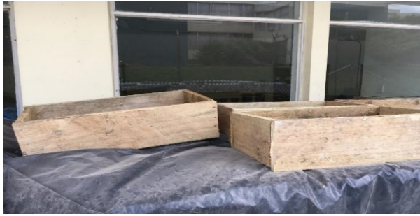
Figura 5: Encofrado tipo para revoco
