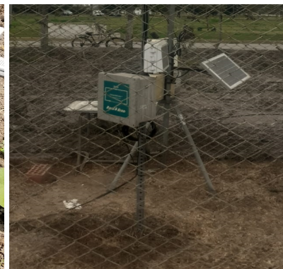
(d) Estación automática Rain Bird-Climate Minder
