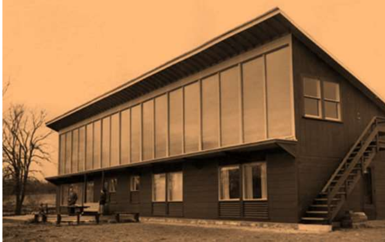
LA CASA SOLAR DE DOVER. FUENTE IMAGEN: MIT ARCHIVES.
